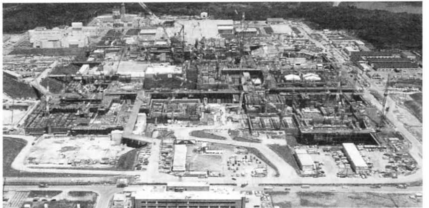
建設現場全景
