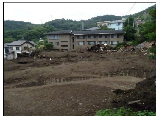
平野部残存した建物
